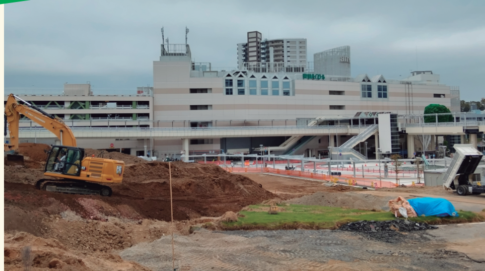
駅前テナント活用型保育園募集中の取手駅前 現在区画整理事業は「A街区再開発」予定地の基盤整備工事中 10月1日撮影
