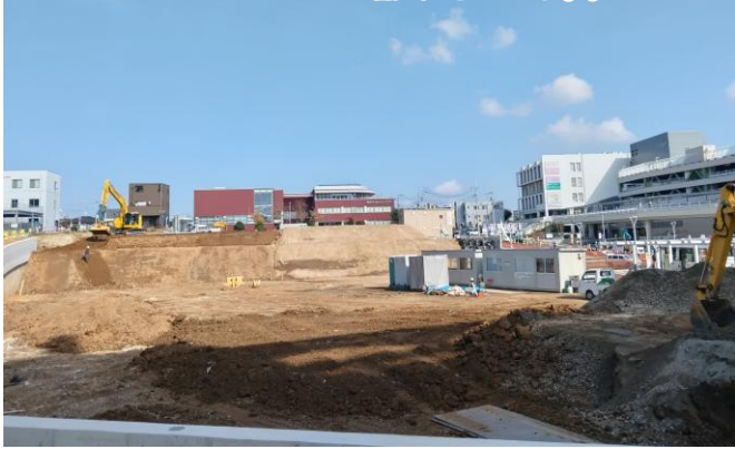
造成工事中の取手駅西口A街区、写真奥にウェルネスプラザ、右側に駅ビル(11月14日撮影)
