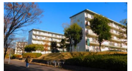
市内UR井野・戸頭団地ともに5階建部分で41・21%の空き室率。これらUR団地の公営住宅への活用も、全国では国やUR等で検討されています。写真は戸頭団地
