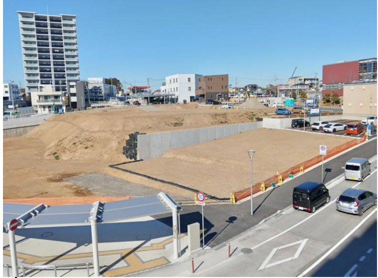
造成工事を終えたA街区、土地利用は地権者に戻された。右奥にウェルネスプラザ、手前低地が再開発不参加区域、奥の高台から低地迄再開発事業用地（1月14日撮影）
