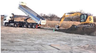
仮設道路造成中の現場に土砂を次々に運び込む 20～30トントラック(12月9日撮影)
