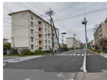
令和7年度に整備された井野団地外周道路(井野集会所前) 8年度は交差点左方面にたいらや前交差点までの整備
