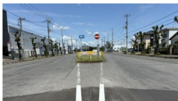
294号線から戸頭公園に続く道路補修が予定されています。
