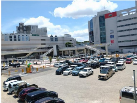
写真手前がA街区再開発予定区域で暫定利用される駐車場、奥の右にリボンビル（5月25日撮影）
