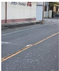
薄くて見えにくい「県道210・谷田部藤代線」藤代地先の停止線と横断歩道
